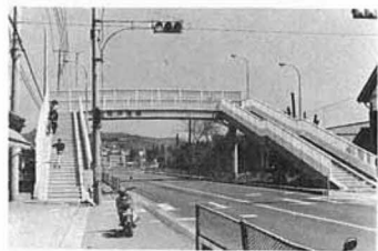
完成した歩道橋
