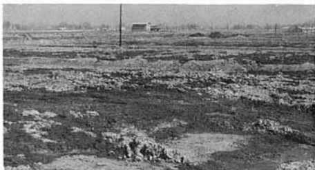
工事中のは場整備事業
