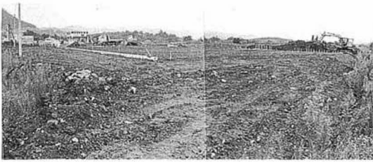
工事中の日向団地
