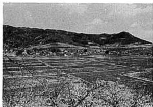
着実に進んでいる基礎整備 (石母田)
