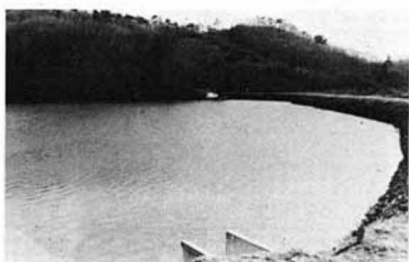
▲ 改修予定の太田沼 (治水対策事業)
