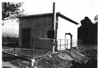
▲ ポンプ場 (高城)
