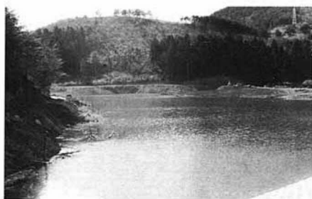
▲漏水対策事業山根溜池完成
