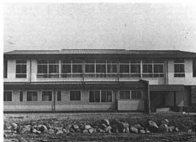
▲完成した国見勤労者体育センター
