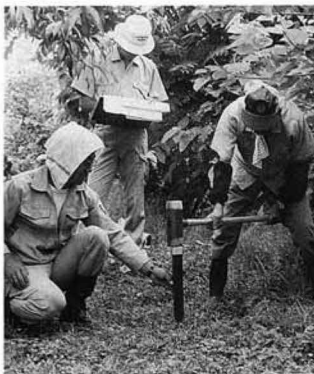
▲長狭物の杭打ち
