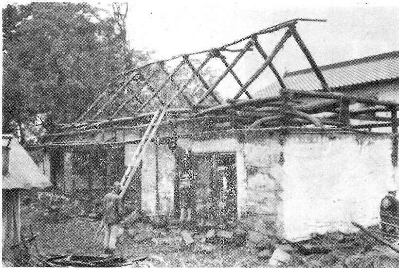
【写真 解体の途中で骨格調査をする】
