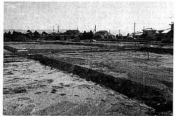
▲完成間近の小林住宅団地
