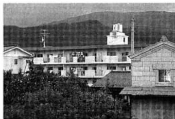
平成4年度に建設された滝山第3団地 (奥の建物)
