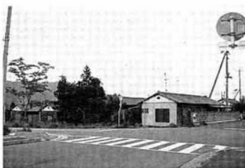
建替される滝山住宅
