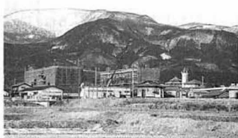
完成間近の雇用促進住宅 (2棟)
