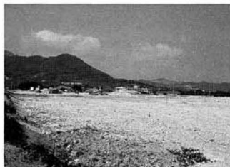
上野台運動広場の建設が進む
