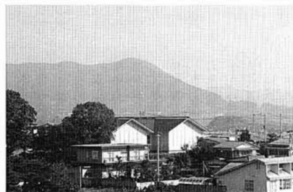
源宗山配水池建設事業（平成5、6年度）
