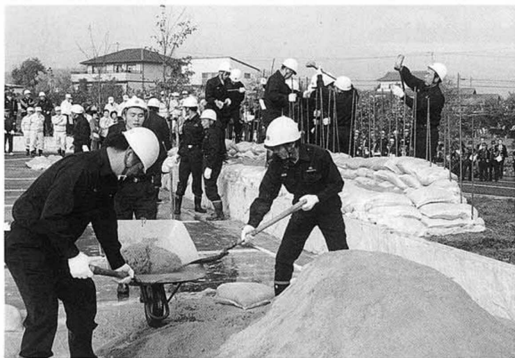
町消防団員の水防訓練（積土のう工法）
