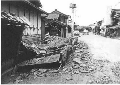
昭和53年(1978年)6月12日、宮城県沖を震源地として襲った大地震では、わが町でも死者1名、負傷者22名、住居の損壊321戸の大きな被害となりました。
