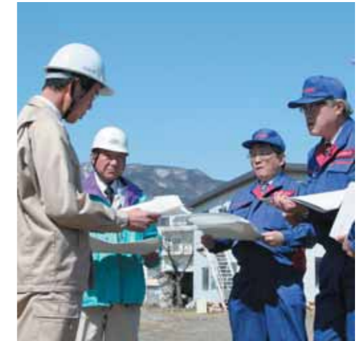
応急仮設住宅の現地確認を行う町長(4月1日) (右端は池口国土交通副大臣、左から2番目が町長)
