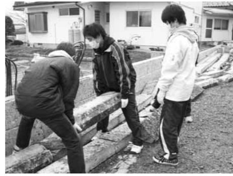
ボランティアによる被害現場の片付け
