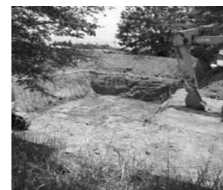
↑ 表土の除去作業の様子（森江野幼稚園） ←除去した表土を埋めるための穴（大木戸小学校）
