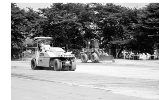
校庭の表土除去の様子
