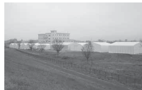
汚泥が仮置きされている浄化センター内のテント
