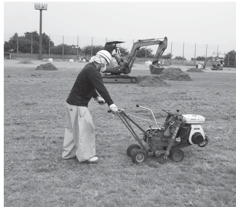
▲上野台運動公園グラウンドの芝を深刈りする作業
