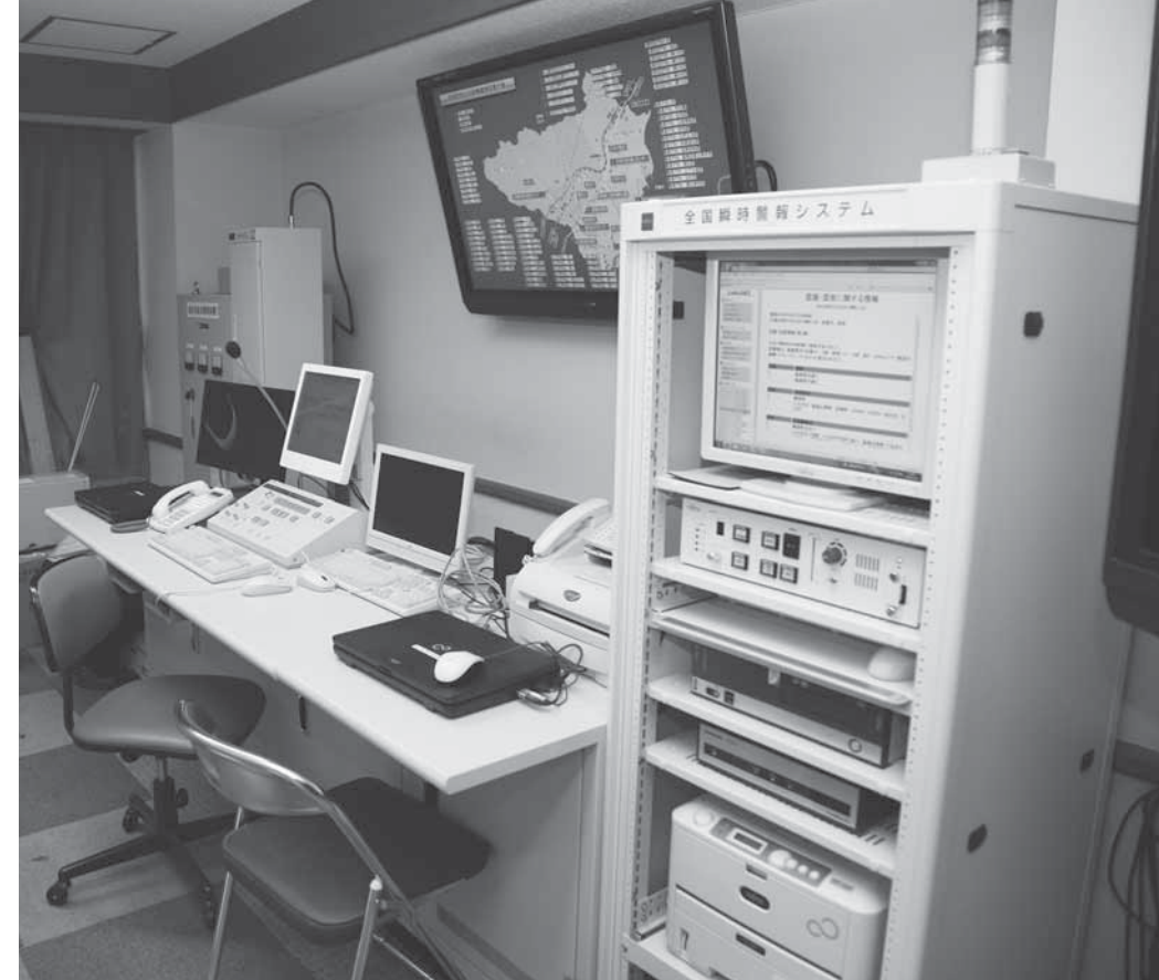
▲役場仮庁舎に設置している全国瞬時警報システム（J-Alert）と防災行政無線
