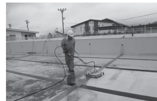
▲上野台運動公園プールの除染作業
