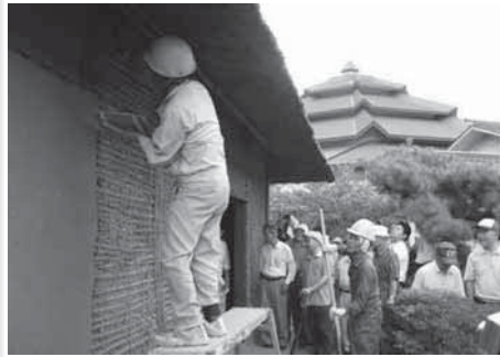
左官による土壁塗り
