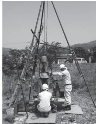
ボーリングによる地盤調査
