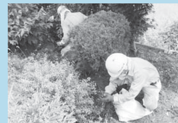
土壌・表土を除去し客土します。汚染状況により剥ぎ取る深さを決定します。
