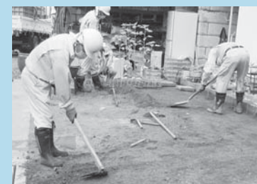
土壌・表土を除去し客土します。汚染状況により剥ぎ取る深さを決定します。
