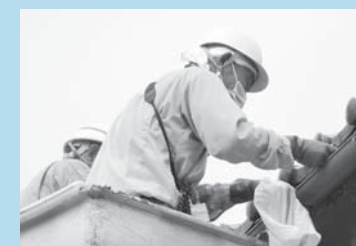
雨樋・堆積物の除去と拭き取りを行います。
