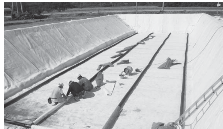
完成が近づく大枝方部第1号仮置場
