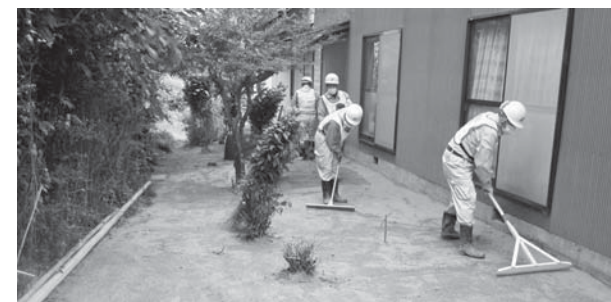
住宅除染の様子
