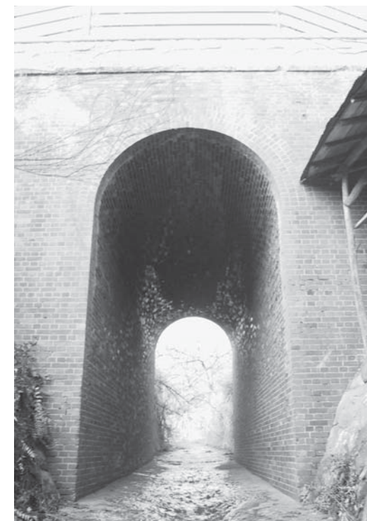
貝田姥神沢旧鉄道レンガ橋
