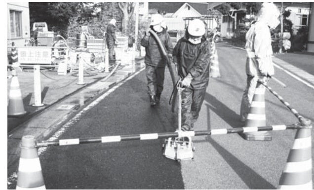
観月台文化センター前道路の除染の様子
