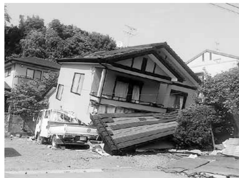
被災したままの家屋が数多く残る現地
