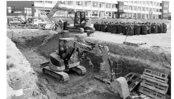
昨年度の国見小学校から搬出作業の様子
