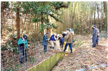
▲新たに侵入防止柵を設置（貝田地区）
