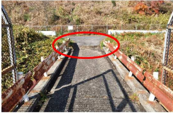
山ノ神前橋：判定区分「Ⅱ」（路面「Ⅲ」） 左：全景（○：損傷箇所） 中：損傷状況 右：補修後（段差摺付け）
