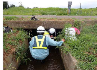
補修設計調査状況(抜粋)
