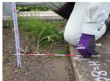
和平橋：判定区分「Ⅱ」（路面「Ⅲ」） 左：全景（○：損傷箇所） 中：損傷状況 右：補修後（段差摺付け）
