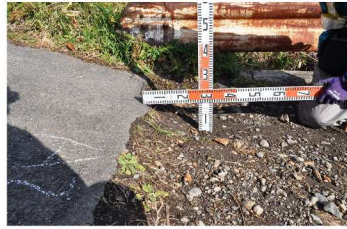
山ノ神前橋：判定区分「Ⅱ」（路面「Ⅲ」） 左：全景（○：損傷箇所） 中：損傷状況 右：補修後（段差摺付け）
