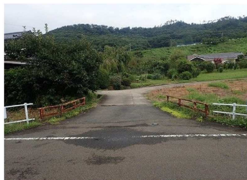
現況写真 (起点側から撮影)
