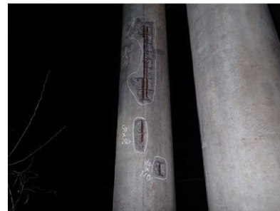
100. 日照田橋：プレテン床版橋 (橋長：27.20m、1965年竣工) パイルベント橋脚の鉄筋露出・うき ※内部鉄筋の腐食の進行は、耐震性能の低下に影響する。(迂回路有)
