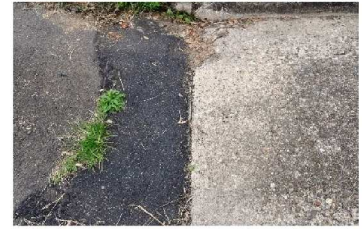
山ノ神前橋：判定区分「Ⅱ」（路面「Ⅲ」） 左：全景（○：損傷箇所） 中：損傷状況 右：補修後（段差摺付け）
