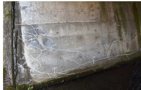
22. 101-2号橋：RC床版橋 (橋長：4.20m、1965年竣工) A1、A2橋台前面のひびわれ (最大幅：1.4mm) ※多数のひびわれの発生により、鉛直支持機能の低下が推測される。(迂回路有)
