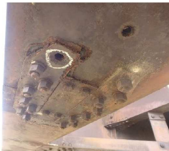
3. 徳江大橋：鋼トラス橋 (橋長：317.20m、1984年竣工) 主構トラス及び横桁添接部のボルトの脱落 ※添接部のボルトの脱落は、耐荷力の低下に影響する。(迂回路有)
