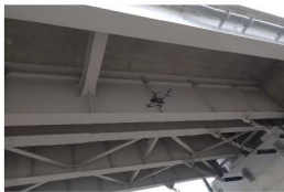
ドローンによる桁下の点検
