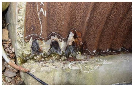
6. 5-5号橋：コルゲートアーチ橋 (橋長：2.60m、1965年竣工) アーチ部材基部付け根の腐食による孔食 ※アーチ部材基部の孔食により、耐荷力の低下が推測される。(迂回路有)
