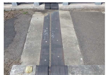
和平橋：判定区分「Ⅱ」（路面「Ⅲ」） 左：全景（○：損傷箇所） 中：損傷状況 右：補修後（段差摺付け）
