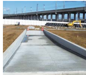
④仮囲いや雨水排水路、タイヤ洗い場等を整備
