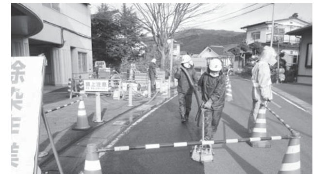
観月台文化センター前道路の除染作業風景
