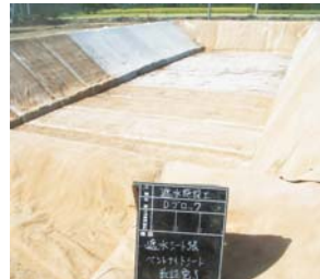
②保護マット敷設の後、遮水シートを敷設
