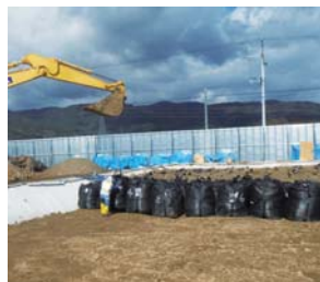
①大型土のう袋の積み込み
