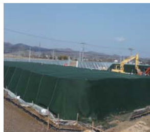
④劣化防止の遮光シートで覆う
