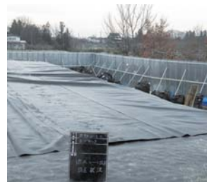
③雨水浸透防止の遮水シートで覆う
