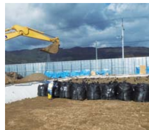
①大型土のう袋の積み込み
