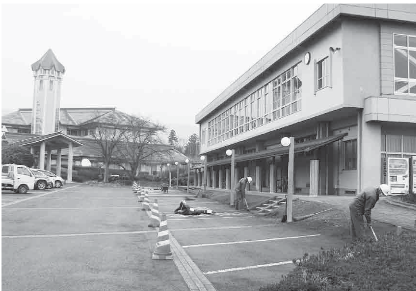
観月台文化センターの除染(芝の深刈り)
