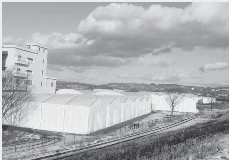
県北浄化センター（汚泥を仮置きするテントが並ぶ）
