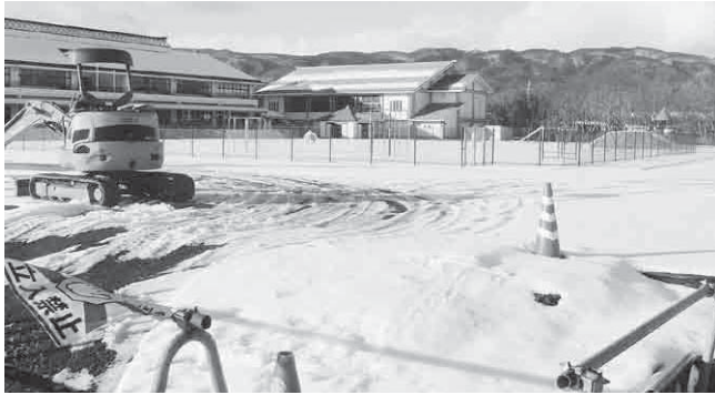
くにみ幼稚園改修工事
