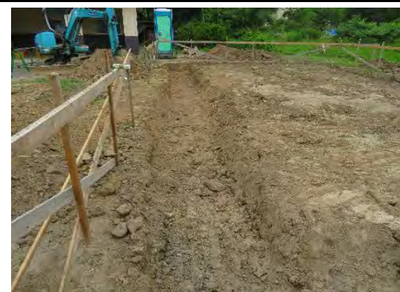
工事立会(中屋敷跡)
