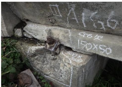
中ノ目橋：支承の腐食、変形
