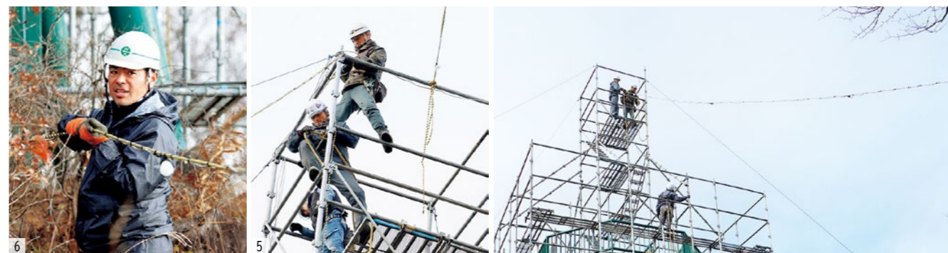
1_足場を組み、最上階から放射状に電飾ロープを張る 2_阿伴の呼吸で作業に取り組み職人たち 3_電球をひとつずつ丁寧に取り付け 4_作業の合間の休憩 5_地上から約15mの高さでの作業 6_長年の経験により素早く作業を行う 7_準備したロープを展望台に移動 8_電飾ロープが外れないように木にくくりつける 9_設営を行った国見町土木建設業協会の皆さんと町内の電気設備会社の皆さん
