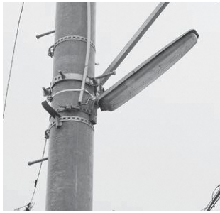
蛍光灯防犯灯
