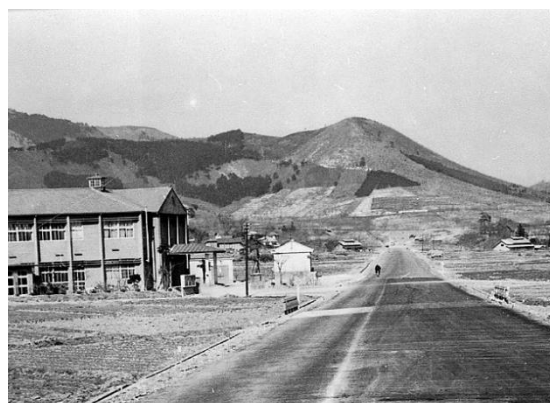
■昭和36年(1961)頃の国道4号整備工事 左の建物は当時の町役場。奥は阿津賀志山
