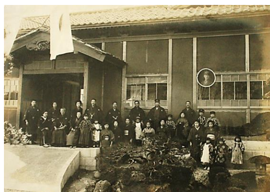
■ 竣工間近の奥山家住宅 大正9年（1920）
