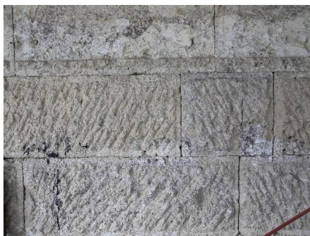
■ 目地にモルタルを用いず隙間がない特徴的な積み方
