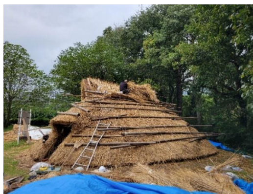
■岩淵遺跡復元住居の茅葺屋根修繕作業
