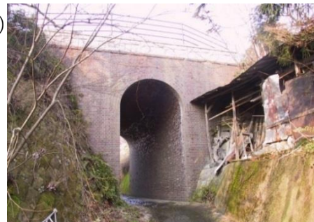
■貝田姥神沢旧鉄道レンガ橋
