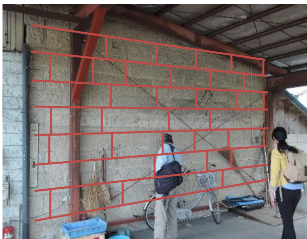
■ 石材規格がバラバラで規則性がない壁体
