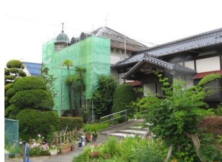
■奥山家住宅洋館 災害による修繕
