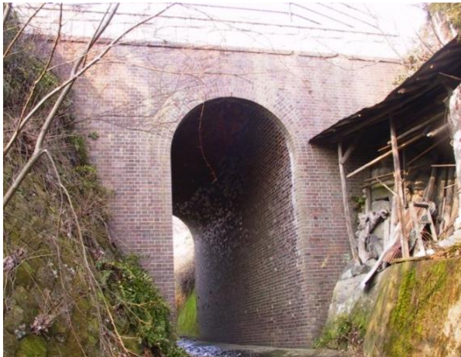
■貝田姥神沢旧鉄道レンガ橋
