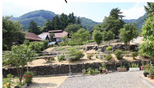
石積みによる平坦地
