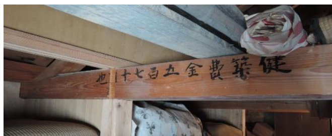
■ 梁を直接壁体に固定している部分(左)と建築費の墨書(右)
