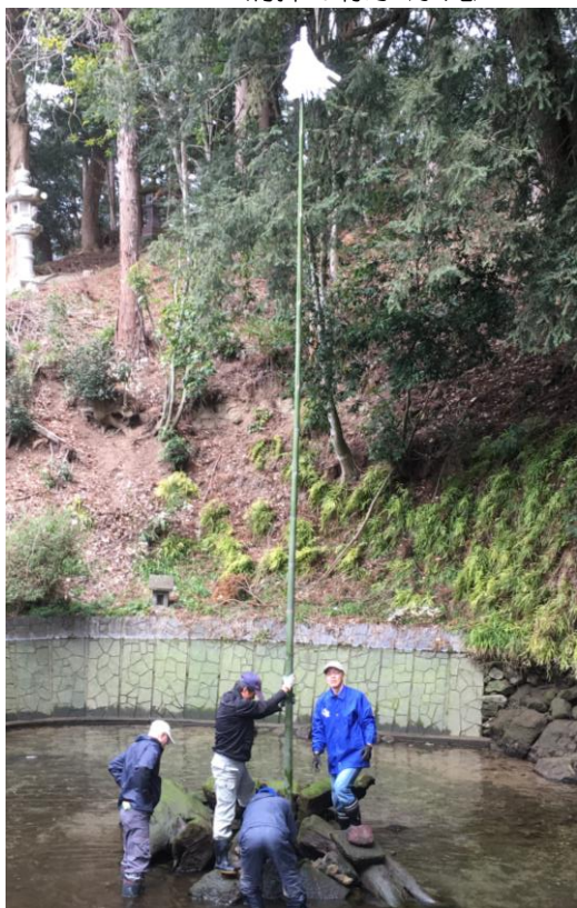
■ボンテンの取り換え作業(大滝)
