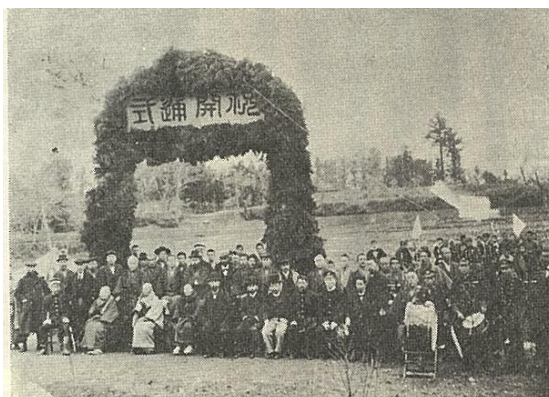
■停車場通りの開通 明治 35 年（1902）
