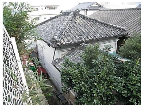
■武田家住宅(旧二文字屋)洋館
