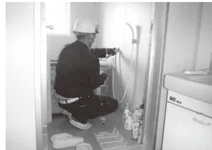
使用料は住宅修繕にも使われています(定住促進住宅)
