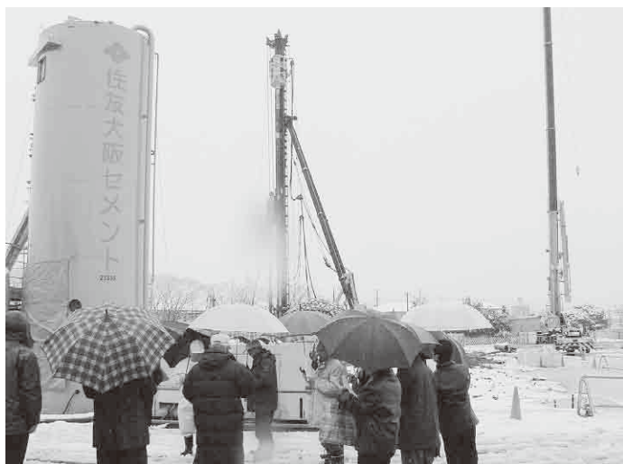
新庁舎の建設現場を確認(旧役場庁舎跡地)
