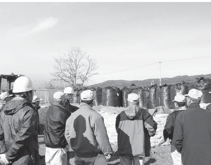
12月12日、3.11大震災復興対策特別委員会で、除去土壌の搬入が進む大枝方部仮置き場を現地調査(西大枝字元寺地内)
