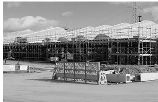
着々と工事が進む道の駅国見あつかしの郷
