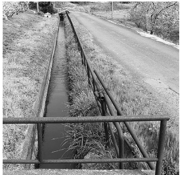
西根堰と隣接の町道(西大枝地内)
