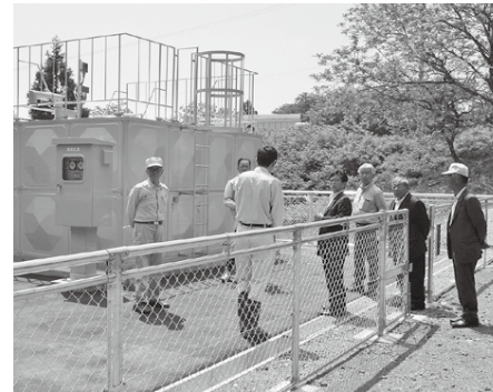
新しくできた赤坂配水池を視察
