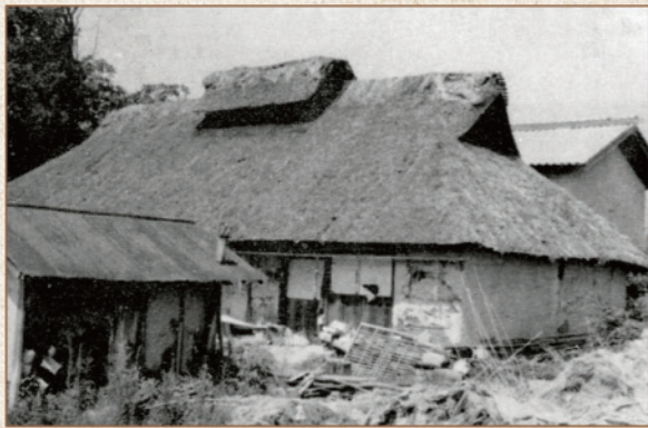
▶復原前の住宅の様子（昭和47年頃） 奥に蔵・手前に納屋が見えます
