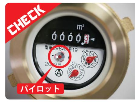
で、メーターが回っているかどうか確認してください。水道メーターの指針の下に、パイロット(シルバークラウド)があります。色で丸いもの)が閉められ、すべての蛇口を閉めた状態でそれが動いていれば漏水とされます。②漏水の場合は、至急町指定給水装置工事業者へ修理を依頼してください。修理代は自己負担となります。
