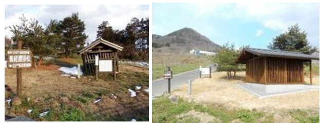
「義経の腰掛松」における老朽化施設の除去と改修
