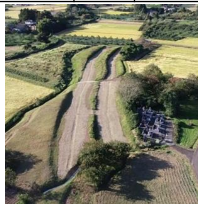
雨水排水設備工事を行った下二重堀地区 (R1.10)
