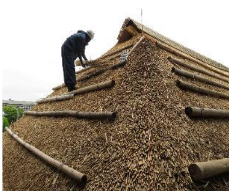
「旧佐藤家住宅」(屋根葺き替え作業実施)
