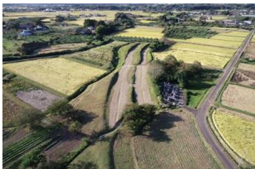
下二重堀地区雨水排水設備整備(工事後)
