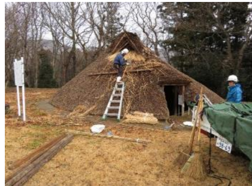
岩淵遺跡竪穴住居跡屋根修繕 (屋根の傷んだ部分の修繕)
