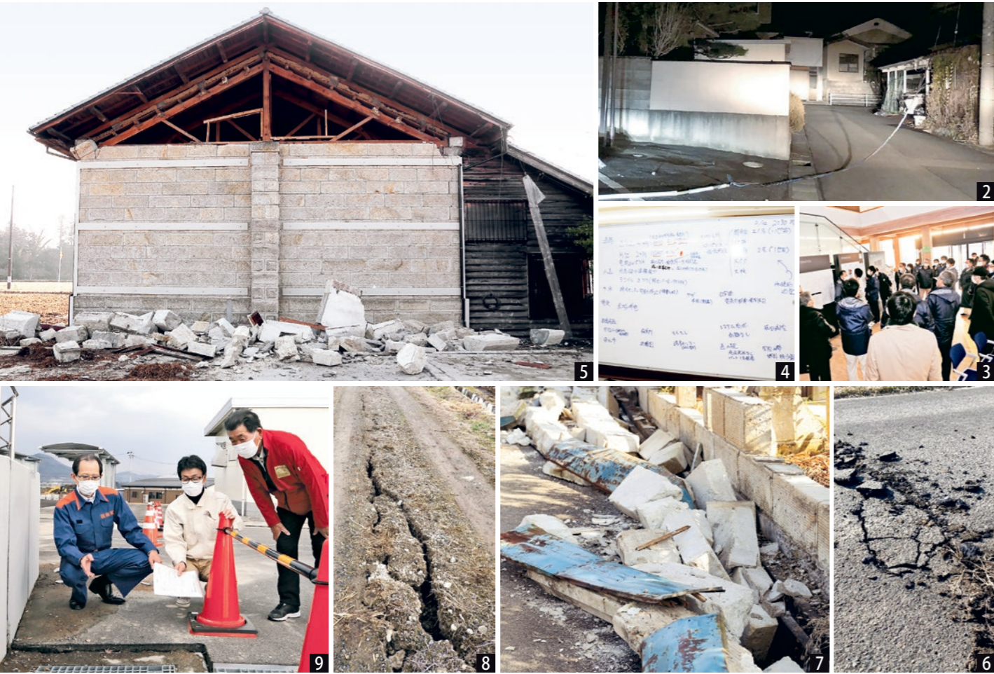
1 大きな被害を受けた道の駅国見あつかしの郷 2 電柱から垂れ下がった電線 3 役場庁舎1階で行われた第1回災害対策本部会議 4 通行止めや被害状況など次々と情報が舞い込んだ 5 石積みの壁の一部が崩れた国登録有形文化財「旧小坂村産業組合石蔵」 6 亀裂が入った町道 7 町内の数か所でブロック塀が崩れた 8 亀裂が入った農道 9 2月21日、道の駅の被災状況の視察に訪れた内堀雅雄福島県知事（左）に被害状況を説明する引地真町長（中央）と朽木勝之国見まちづくり株式会社社長（右） 10 2月19日に営業を再開した道の駅では落下被害を免れた地酒やジュースなどを「震度6強を乗り越えた勇者達」と名付けて販売
