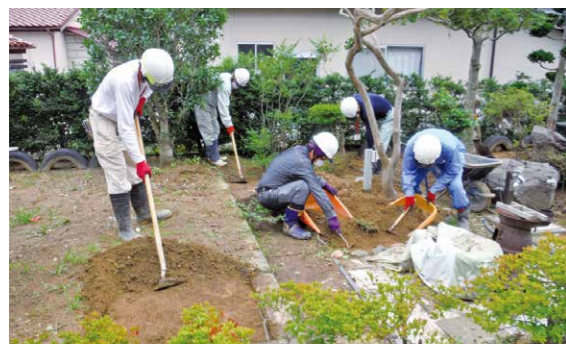
住宅の庭の除染作業
