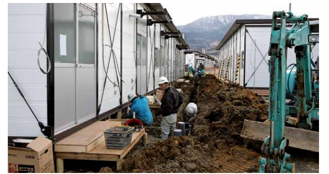
県内でもいち早く仮設住宅の建設がはじまった
