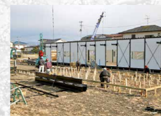
急ピッチで進められた仮設住宅の建設
